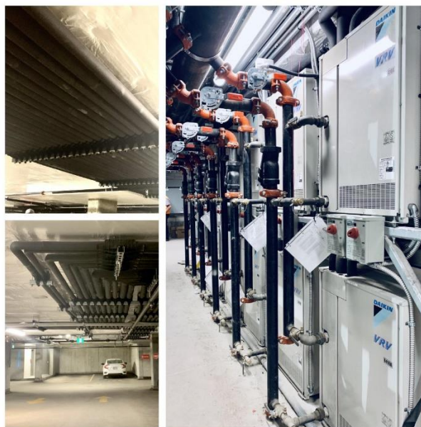
Слика 4-8 – Типична инсталација централних јединица VRF система са воденим кругом
