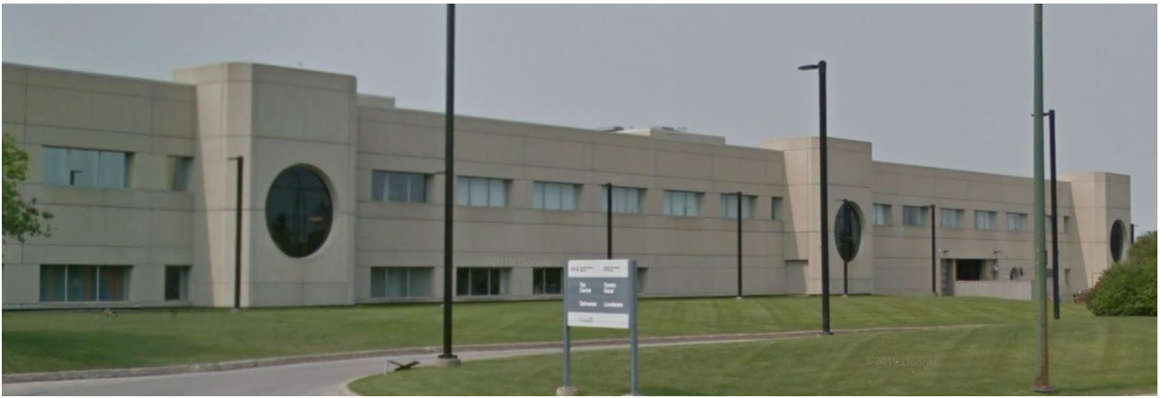
Слика 3-2 – Карактеристичан изглед фасаде објекта (северна страна)
