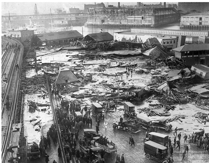
Slika 2.2 Poplava usled krtog loma rezervoara za skladištenje melase u januaru 1919. izazvana i neodgovarajućom prelaznom temperaturom korišćenog materijala za izradu skladišta [6]
