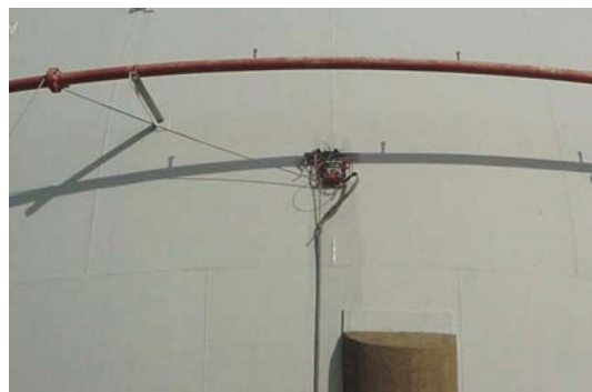
Slika 13. P-SCAN kontrola zavarenog spoja na sfernom rezervoaru
