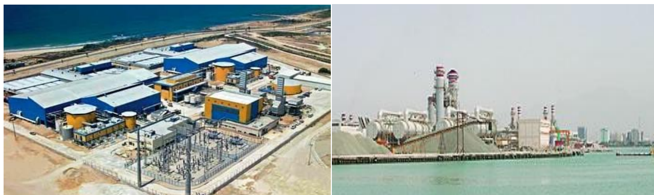
Slika 1: Postrojenja za desalinizaciju
