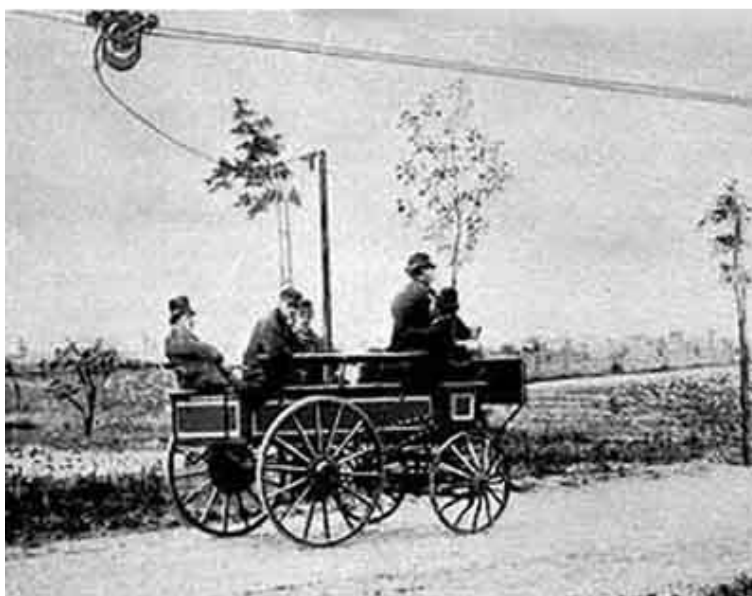
Slika 1.3. – Simensov autobus na električni pogon iz 1882. godine
