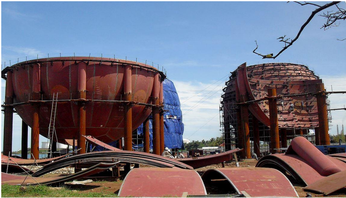
Slika 1.13. Izgradnja nadzemnog čeličnog rezervoara (sklapanje na mestu ugradnje)
