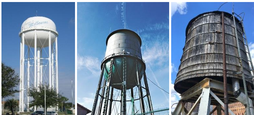
Slika 1.2. Izgled čeličnog i drvenog rezervoara za vodu
