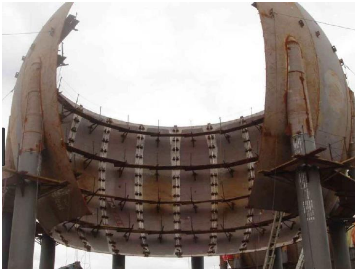
Slika 1.19. Izrada sfernog rezervoara
