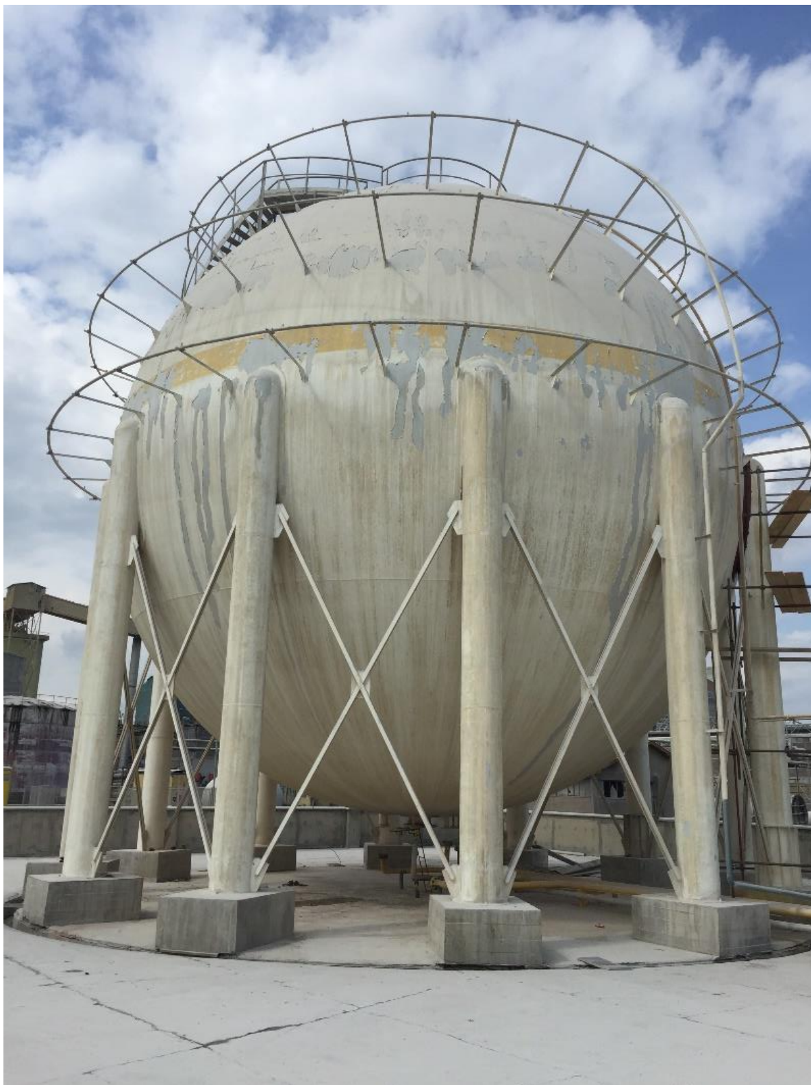
Slika 1.20. Izgled sfernog rezervoara za tečni amonijak ( \text{NH}_3 )
