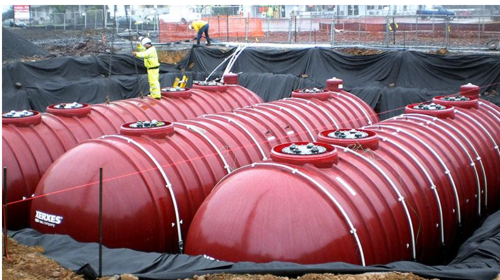
Slika 1.12. Postavljanje podzemnih čeličnih rezervoara
