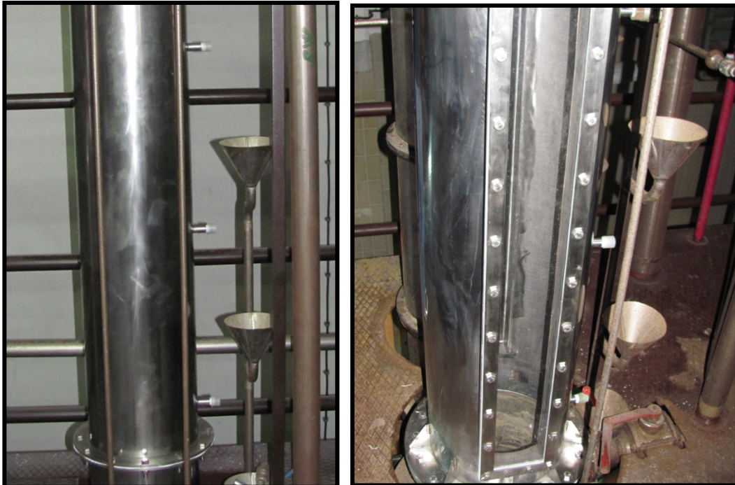
Slika 5. – Izvedeno stanje druge sekcije jedne od kolona i prve sekcije kolone sa revizionim otvorom
