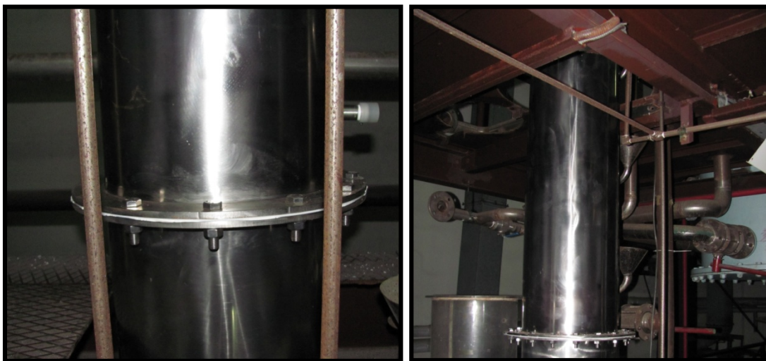
Slika 6. – Prirubnički spoj sekcija kolone i prolaz kolone kroz drugi nivo pristupne platforme
