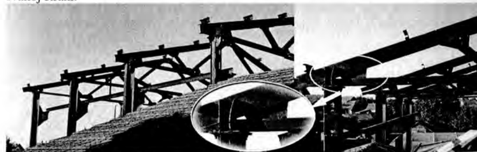
Slika 5 – Izrađena konstrukcija i završetak faze montiranja krovnih nosača
