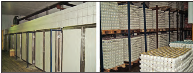
Slika 3. Male rashladne komore (levo) i skladišna komora (desno)
