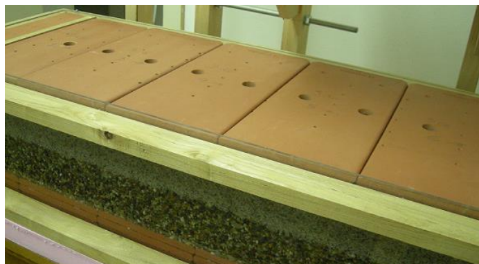
г) постављање горњег непрпусног слоја
