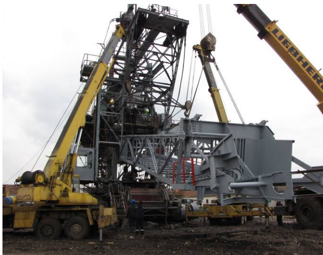
(а) монтажа стреле ротора
