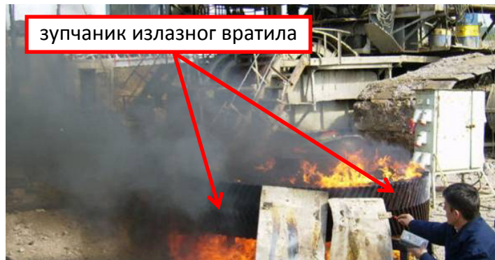
Слика 5. Загревање зупчаника пре монтаже
