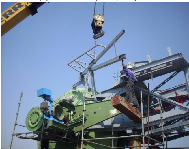
(в) монтажа дела кровног носача
