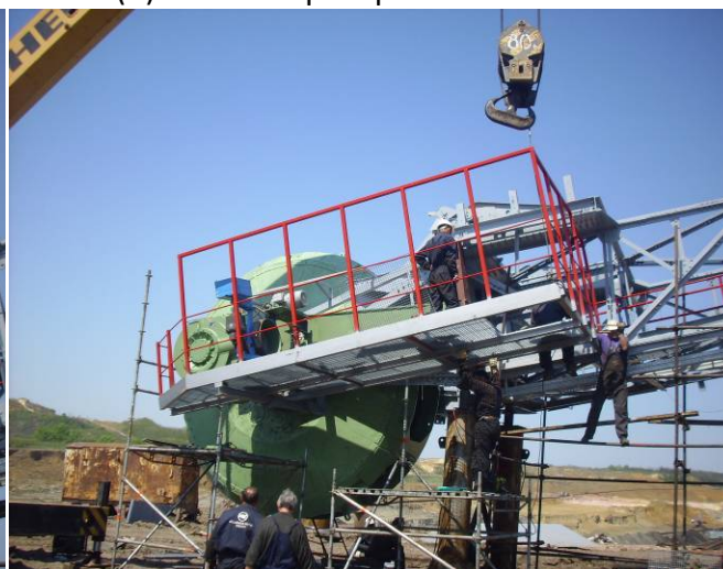
(г) монтажа платформе
