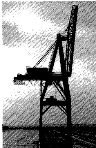
Слика 5. Пакеко дизалица СЛ7 (1964) Figure 5. Pacesco crane SL7 (1964)
