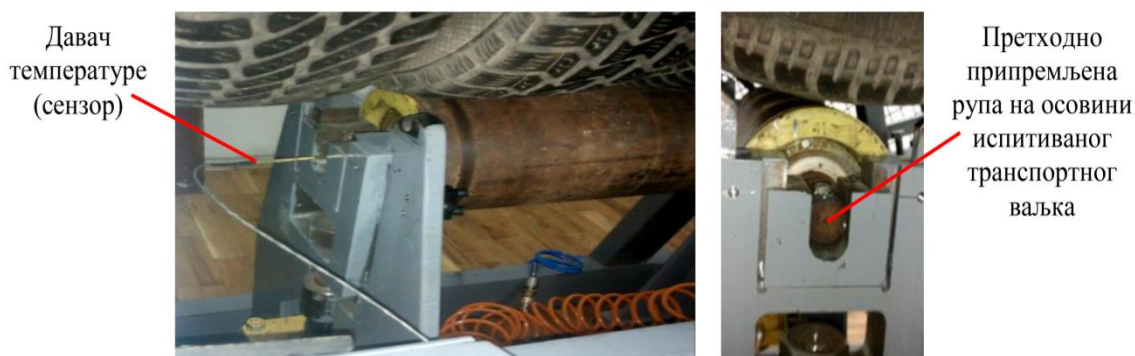
Слика 4.11: Монтажа давача температуре
