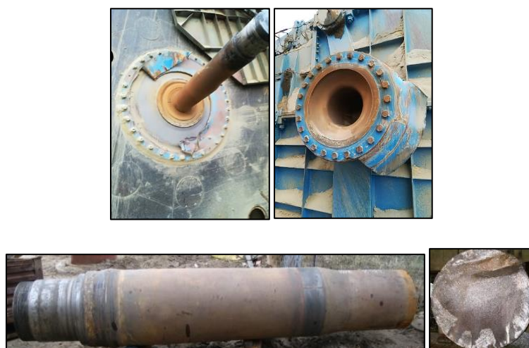
Slika 2.1. Problematika pogona rotora bagera SRs 2000 (bager I)
