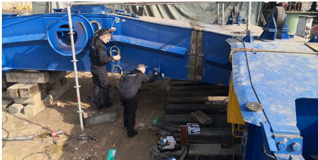
(б) конструкција у фази монтаже
