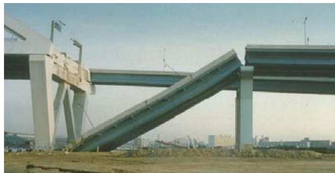
Слика 2.4. Оштећења услед губитка ослонца (Кобе, 1995)
