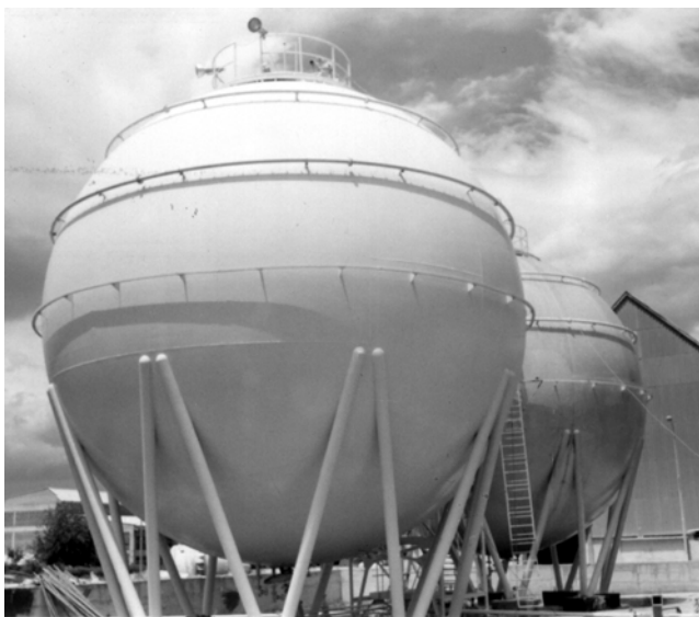
Slika 1. Sferni rezervoar za tečni amonijak
