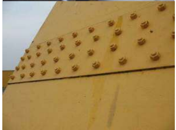
Slika 4.1.6.4 Stanje spoljašnosti karakterističnih elemenata na vijčanim vezama "b" i "c"
