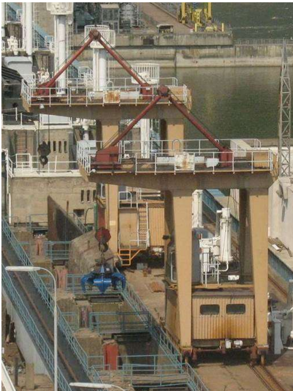
Slika 4.2.1 Sistem dizaličnog transporta na ulaznoj građevini HE Đerdap 1
