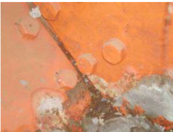
Slika 4.1.6.2 Stanje konstrukcije krute noge na mestu veze "d" iznutra, rečna dizalica
