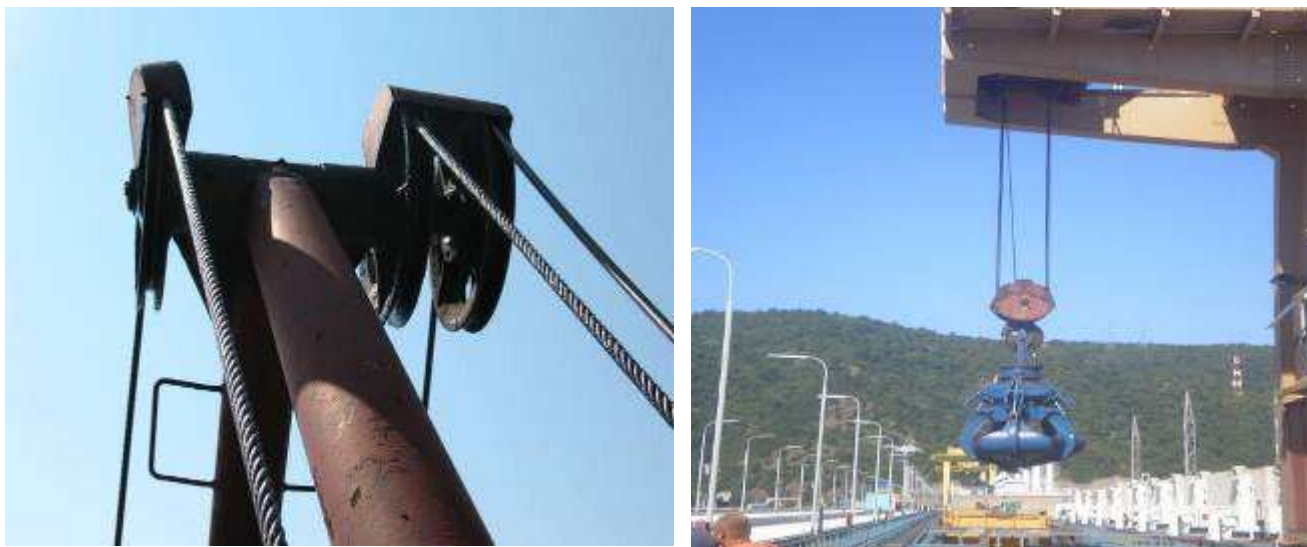
Slika 4.2.1.1 Vizuelna kontrola stanja mehanizama za dizanje rečne i obalne čistilice
