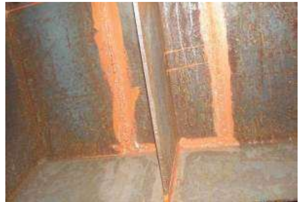
Slika 4.1.6.2 Stanje konstrukcije krute noge na mestu veze "d" iznutra, rečna dizalica
