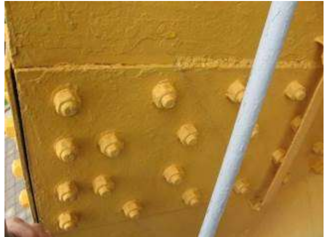
Slika 4.1.6.3 Stanje konstrukcije krute noge na mestu veze "d" iznutra, obalna dizalica
