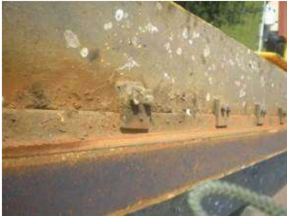
Slika 4.1.5.3 Šina na glavnom nosaču, poprečni vezni nosač dva glavna nosača i gazišta
