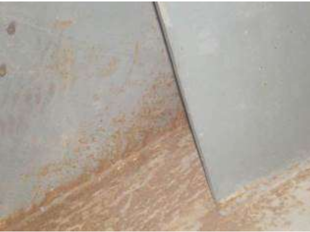
Slika 4.1.6.3 Stanje konstrukcije krute noge na mestu veze "d" iznutra, obalna dizalica
