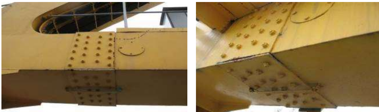
Slika 4.1.6.7 Stanje vijčanih veza “e , f” i poklopaca “g”
