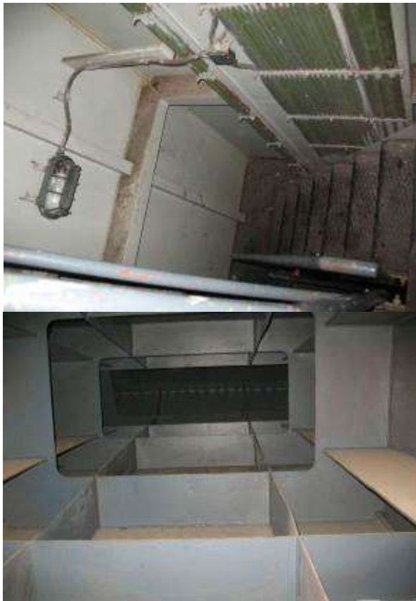
Slika 4.1.6.5 Unutrašnjost konstrukcije središnjeg dela krute noge
