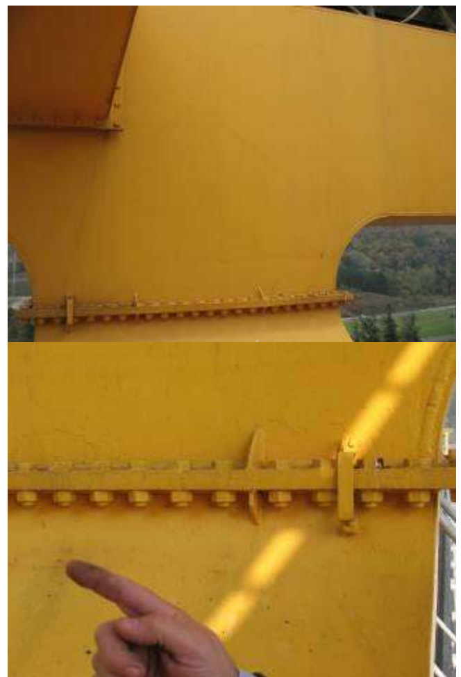
Slika 4.1.5.4. Veze poprečnih nosača sa glavnim nosačima i veza glavnih nosača sa nogama dizalica
