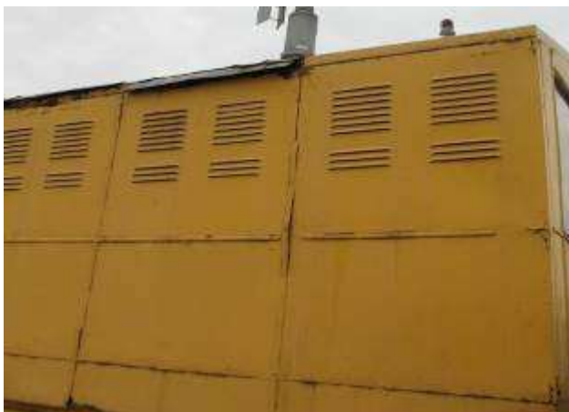
Slika 4.1.3.4 Stanje konstrukcije kućica kolica mehanizama za dizanje na obe portalne dizalice
