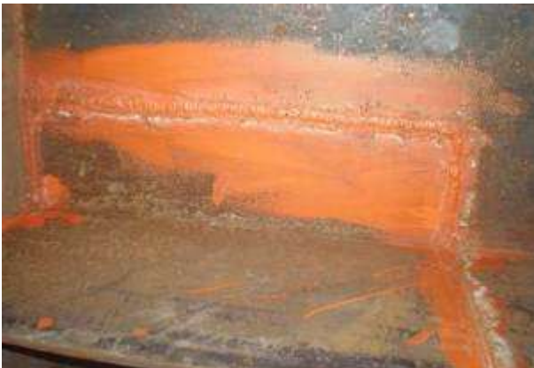
Slika 4.1.6.2 Stanje konstrukcije krute noge na mestu veze "d" iznutra, rečna dizalica
