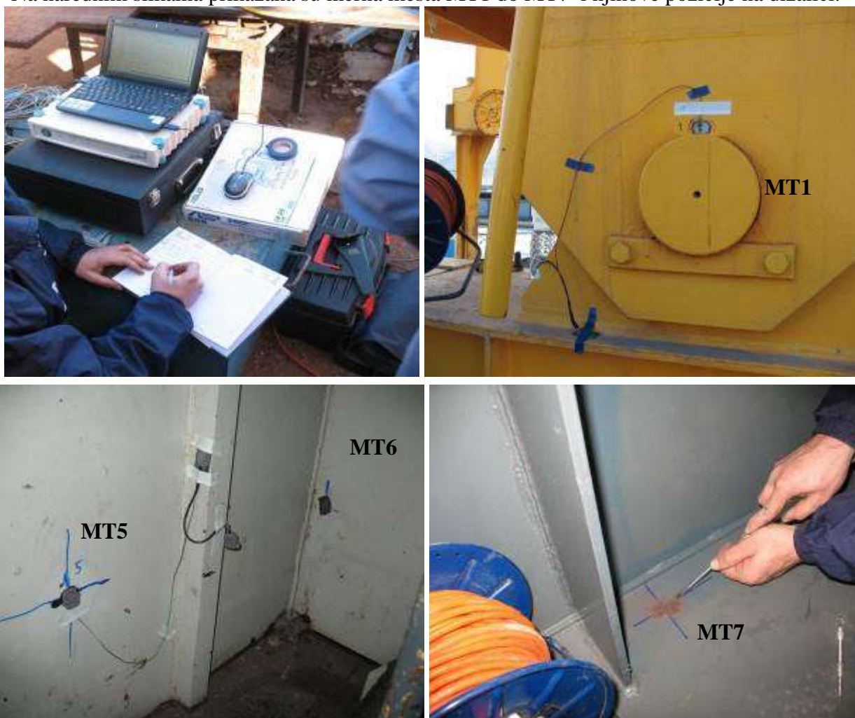
Slika 4.1.10.1 Merna oprema, merna mesta MT1, MT5, MT6 i MT7
