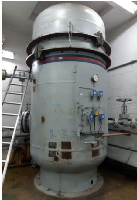
Slika 41. c) Specijalno dizajnersko rešenje za SP 970: ukrutni prsten oko lokacije defekta 5.6
