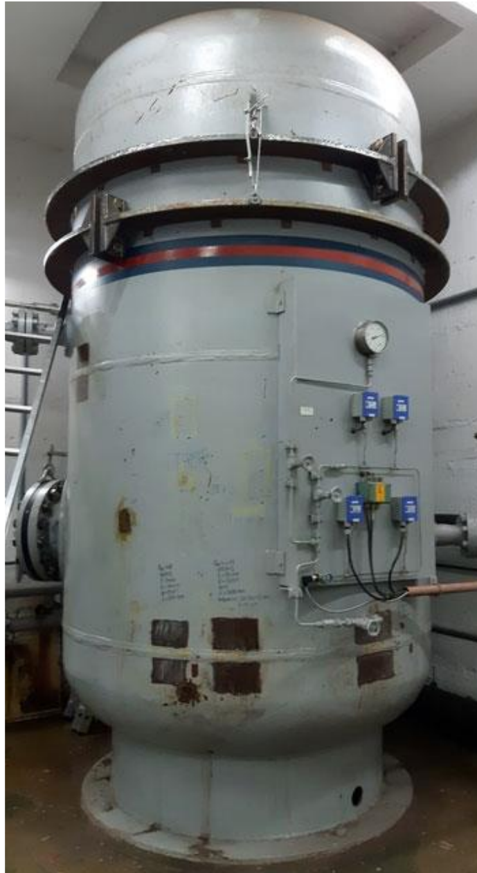
Slika 5. Posuda pod pritiskom nakon postavljanja ukrutnog prsten
