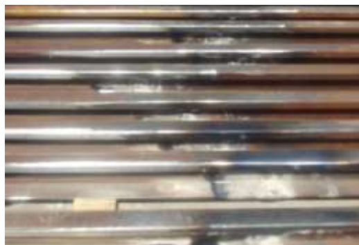
Slika 5 - Gazeće površine zavarenih šina i makrostruktura zavarenog spoja
