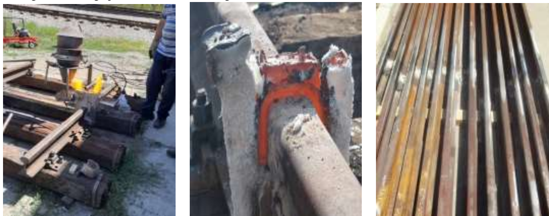
Slika 4 - Izrada zavarenih spojeva
