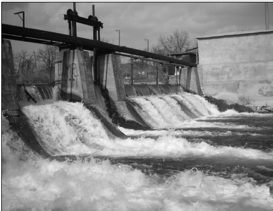
Slika 1 Fotografija sagrađene MHE i postojeće brane sa dograđenim ustavama na njoj
