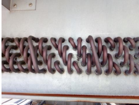
Slika 2.1 Raspored cevi na razmenjivaču toplote
