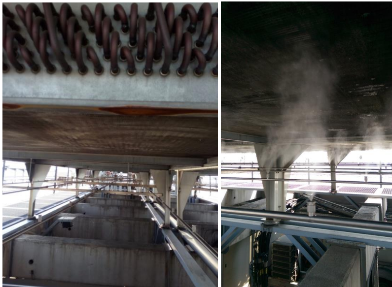
Slika 2.2 Razmenjivač toplote sa mlaznicama za raspršivanje vode – rad bez i sa orošavanjem
