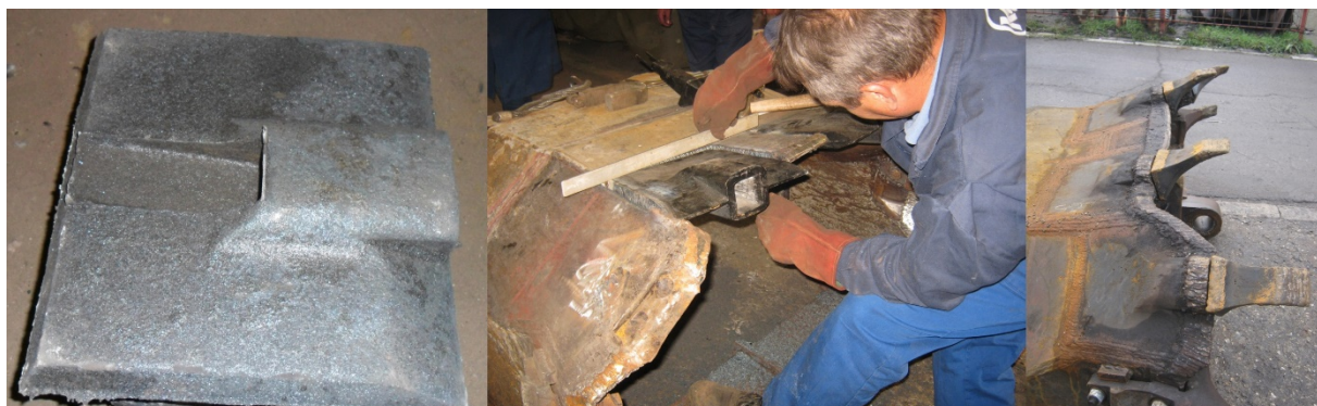
Slika 5. Nosač zuba, montaža, kašika bagera
