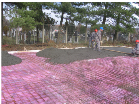
Slika 5. Prekrivanje betonskom košuljicom
