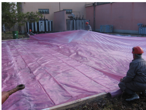
Slika 3. Prekrivanje sorbenta polietilenskom folijom
