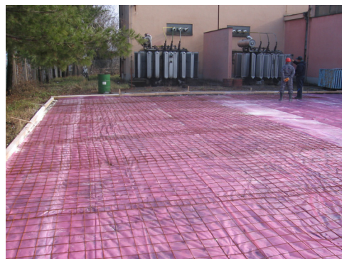
Slika 4. Prekrivanje folije armaturnom mrežom
