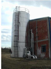
Sl. 2. Fotografija AT na kotlu u Padinskoj Skeli Fig. 2. Photography of TST in boiler at Padinska Skela
