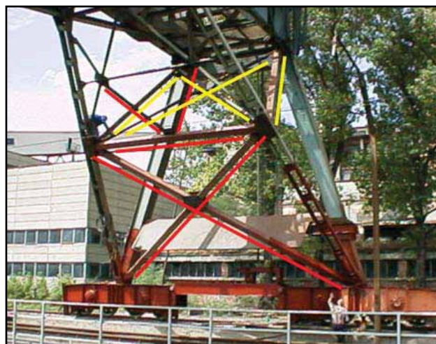
Slika 31. Izgled strukture u zoni krute noge nakon rekonstrukcije
