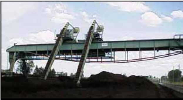
Slika 2. Pretovarni most za uglj Metalna 300
