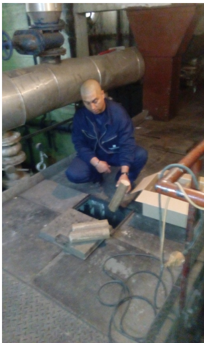
Slika 2. Rukovalac kotlovskog postrojenja Maljenska 3
